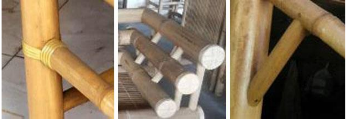
Gambar 79. Konstruksi purus , purus tembus dan kawang
